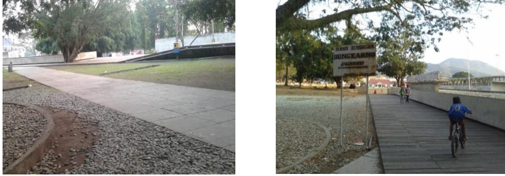
Gambar 12. Keutuhan jalur jalan
